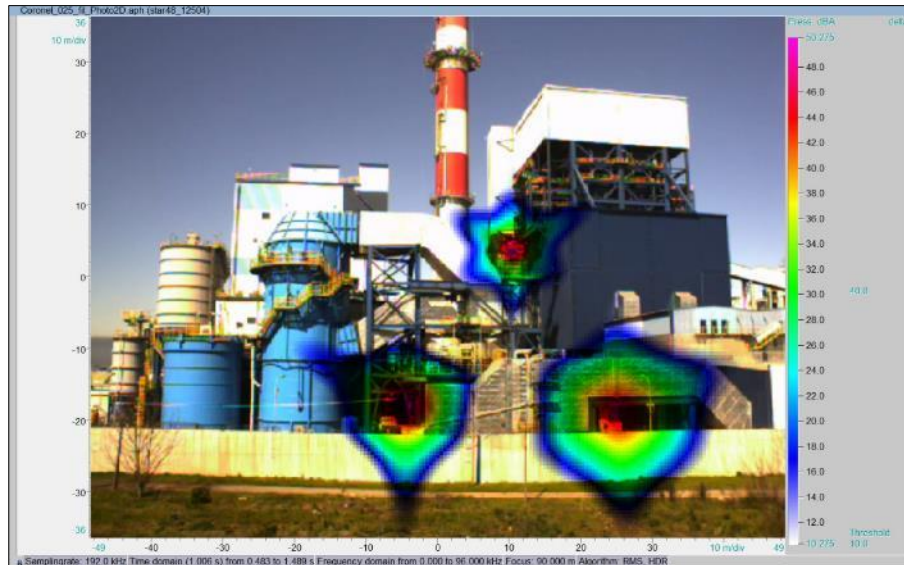
Figura 40: Identificación de fuentes predominantes para determinar potencia acústica asociada. Central Bocamina, Coronel. 39
