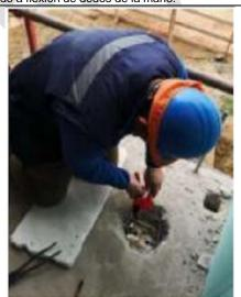
Se observa la operación de Reparación de la filtración, donde corta excedente de cañería con tijera de PPR. Se observa extensión de muñeca derecha.
