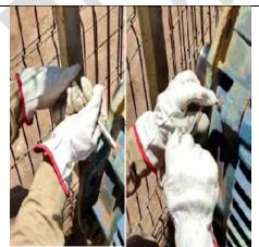
Retiro de pernos: Esta operación se realiza con una o ambas manos, se observan movimientos combinados y compresión de la base del pulgar. Dependiendo de la posición del perno puede variar la toma de la herramienta.
