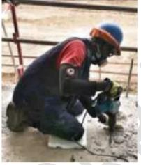
Se observa operación de Picado de piso de cemento. Se utiliza martillo demoledor, con todos los EPP. El trabajador señala que la operación dura 40 minutos, tras lo cual hace una pausa de 5 minutos aproximadamente y continua. Se observa flexión y desviación cubital de muñeca derecha, asociado a flexión de dedos de la mano.
