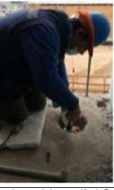
Se observa otra imagen de la operación de Reparación de la filtración. En esta etapa de la operación se realiza la polifusión, que consiste en el proceso de ensamblado de las piezas PPR, donde sostiene con su mano derecha la cañería y con la izquierda sostiene la máquina termofusora, ejerciendo presión mientras se calienta la cañería, para luego ensamblarlo con la otra. Se observa flexión de muñeca y desviación cubital de muñeca derecha.
