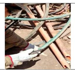
Cortar cubierta de cable: El trabajador utiliza un cuchillo cartonero para guiar el corte y un alicate de corte, para lo definitivo. Se observa flexión de dedos asociado a fuerza.
