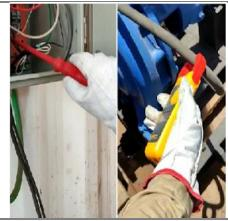
Verificación de electricidad: Operación que se realiza en algunas de las inspecciones, pero sí se realiza diariamente. Se presenta tiempo breve de exposición. Puede utilizar tester Fluker, destornillador o ambos para la inspección. Opera la herramienta con la mano derecha habitualmente. Se observa compresión sobre el pliegue palmar distal asociado a flexión de uno o más dedos.
