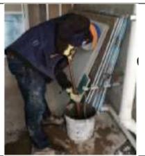
Se observa operación de Búsqueda de filtración. Se realiza una prueba hidráulica, que consiste en bombear agua hacia las cañerías PPR hasta alcanzar una presión de 150 bar, lo que permite identificar las filtraciones que luego debe reparar. Presenta bastante resistencia cuando se aproxima a la presión de 150 bar, debiendo el trabajador aplicar más fuerza. Los tarros con agua para hacer esta prueba deben traerlos desde otro sitio. Se observa flexión de muñeca y dedos de la mano derecha.
