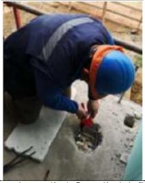
Se observa la operación de Reparación de la filtración, donde corta excedente de cañería con tijera de PPR. Se observa extensión de muñeca derecha.
